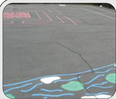
Fisuras en asfalto debido a una cavidad
